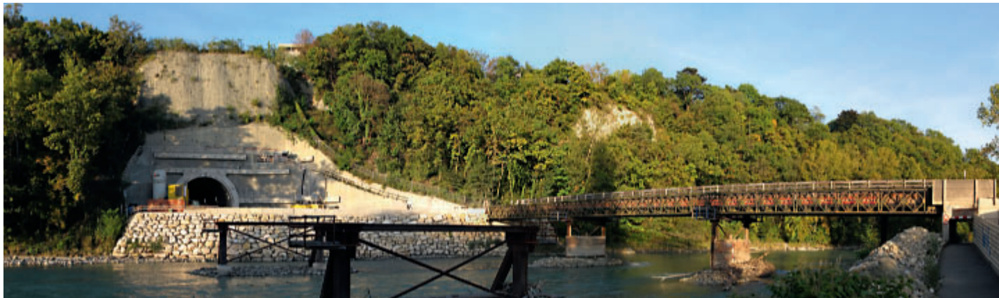
Chantier pour les travaux du CEVA au lieu-dit Val d'Arve.
