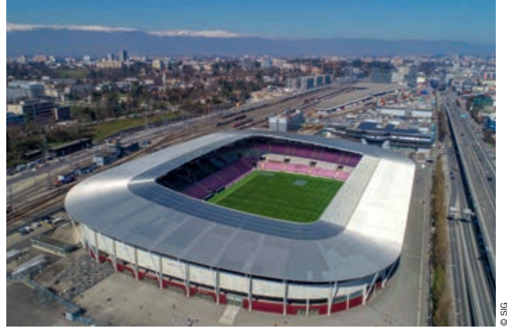
Le toit du Stade de Genève, sur lequel 5000 m 2 de panneaux photovoltaïques seront installés. Ils permettront de couvrir la consommation annuelle de 367 ménages genevois.
