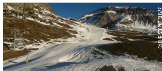
Les remontées mécaniques et le système d'enneigement artificiel consomment de l'électricité
